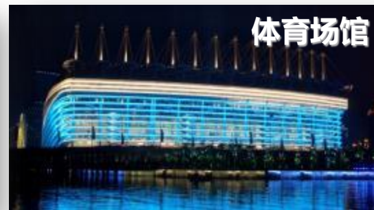
广州海心沙体育场、重庆空港体育馆、 北京大学体育馆
